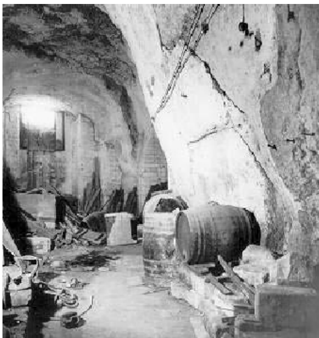
Una cavità del sottosuolo trasformata in una vera stanza
